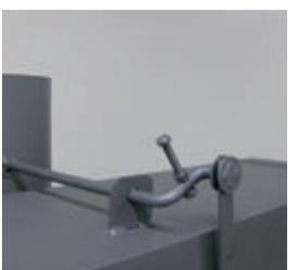
RÉGLAGE DU CLAPET DE FUMÉE
